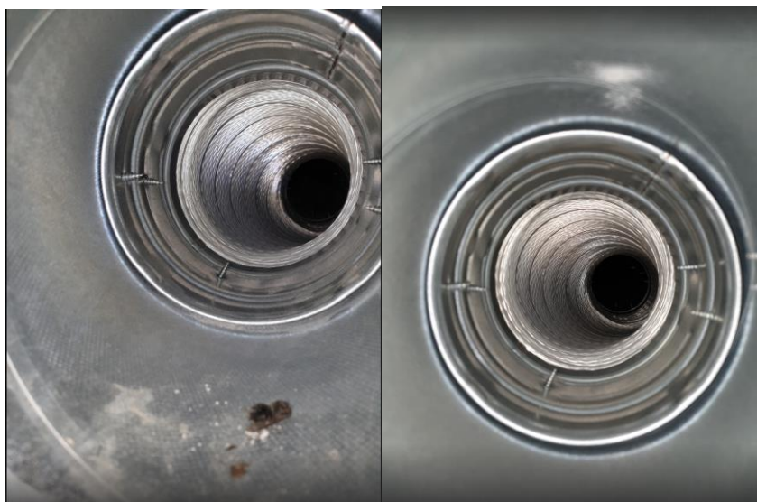
Før / til-luft soverom flue & støv
