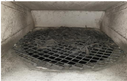
Før / inntak kanal
