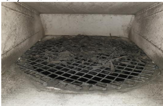
Før / inntak kanal
